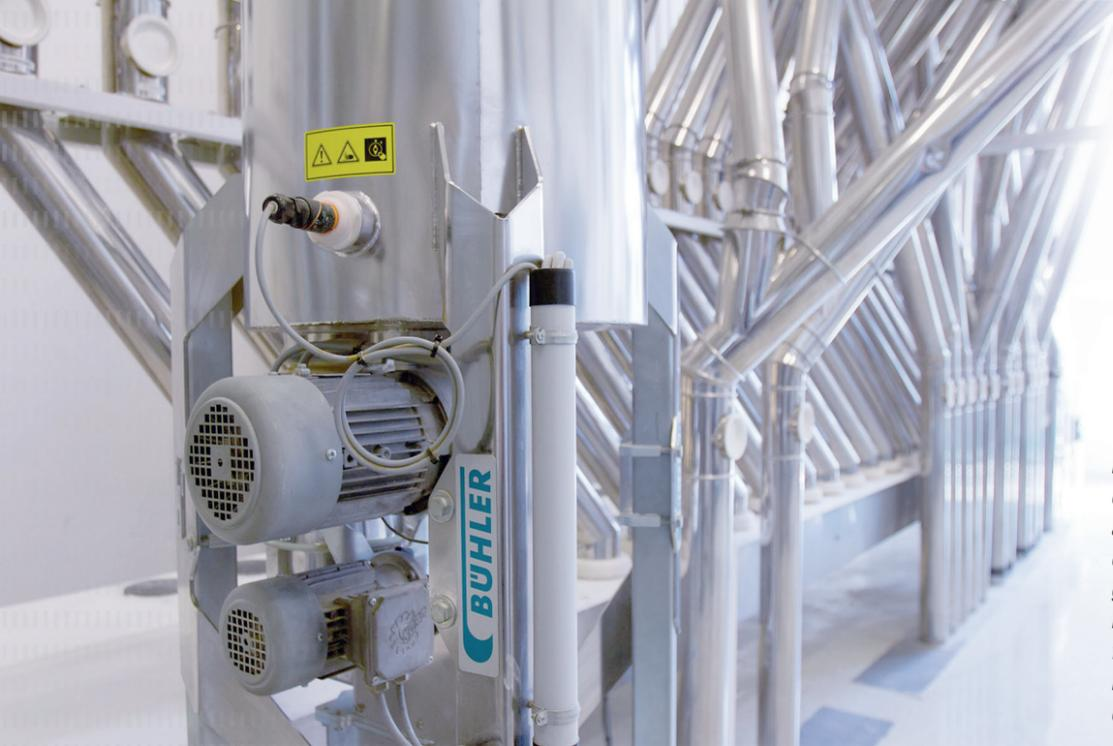
Les entraînements électriques assument de nombreuses tâches dans les moulins au niveau des ventilateurs et soufflantes, des alvéoles de dosage, des élévateurs à godets et autres installations de transport. Dans le domaine des céréales et graines finement moulues, des systèmes NORD DRIVESYSTEMS protégés contre les explosions sont utilisés.
