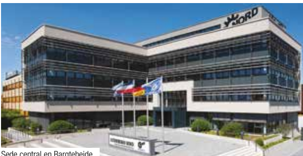
Sede central en Bargteheide
